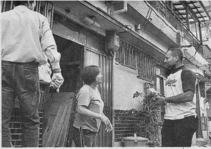
「OSAKAなんみんハウス」のオープンに向け、玄関や部屋を改修する支援者たち＝大阪市淀川区
