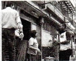
「OSAKAなんみんハウス」のオープンに向け、玄関や部屋を改修する支援者たち＝大阪市淀川区
